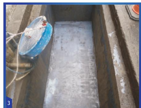
3 يتم اصلاح الزوايا المنحدرة مع ملاط الاصلاح لتسريع جفافه وبالخصوص الاماكن المغلقة ويجب استخدام نوع من السخانة الكهربائية لدوران الهواء PL207 يطبق ولرؤية زخرفية يطلى بلون ازرق
