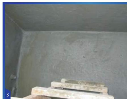
3 يتم اصلاح الزوايا المنحدرة مع ملاط الاصلاح لتسريع جفافه وبالخصوص الاماكن المغلقة ويجب استخدام نوع من السخانة الكهربائية لدوران الهواء PL02 يطبق ولرؤية زخرفية يطلى بلون ازرق
